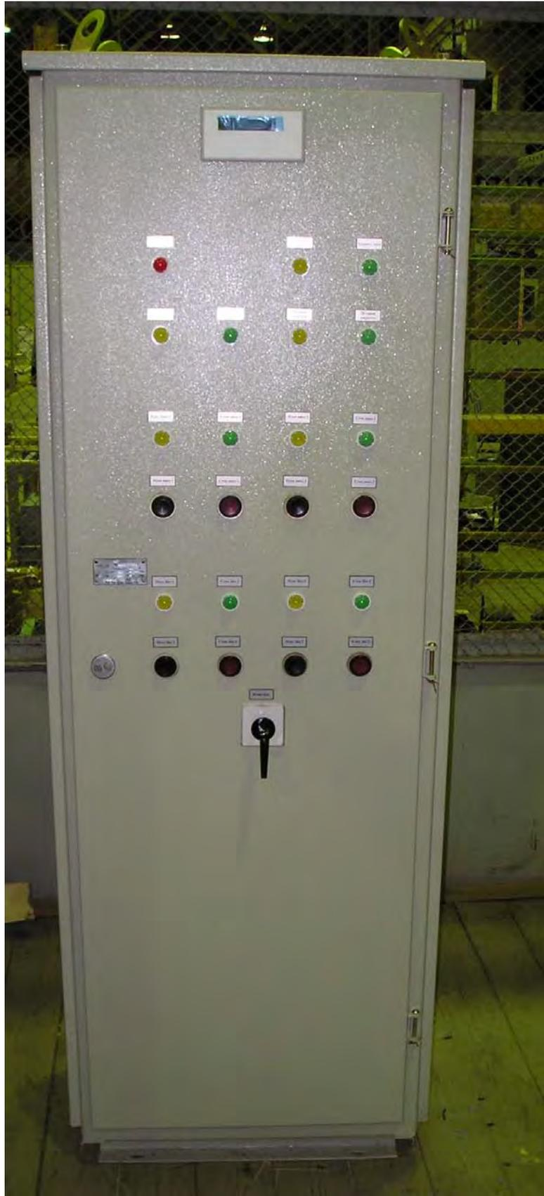
**Шкаф АВР на базе микропроцессорных блоков Siemens**
