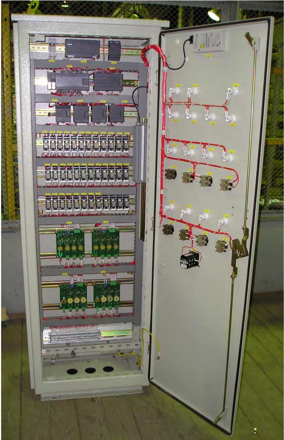
**Шкаф АВР на базе микропроцессорных блоков Siemens**
