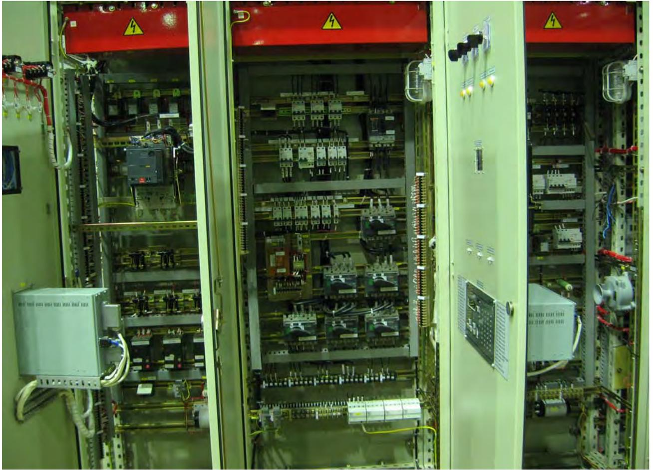
Шкафы ввода на базе блоков БМРЗ и БМПА (ООО «НТЦ «Механотроника»)
