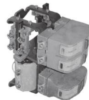
Контактор серии МК на ток 40 А с главными контактами: 2"3" и 1"Р"
