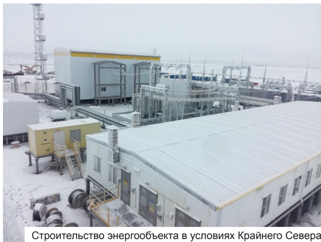
Строительство энергообъекта в условиях Крайнего Севера
