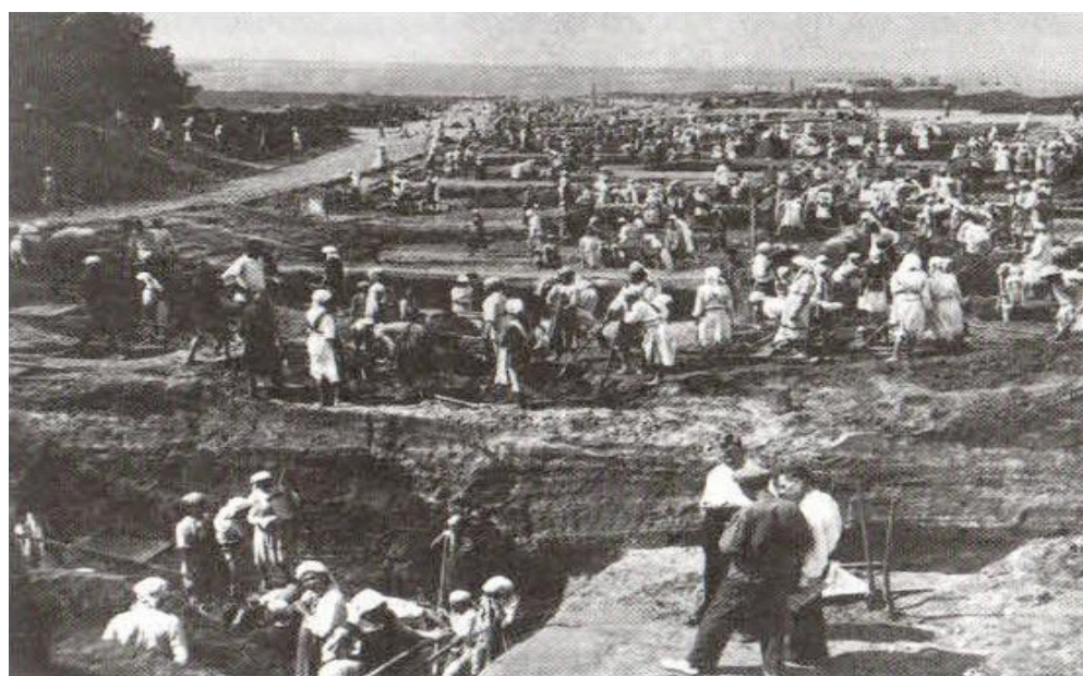
Колхозники на строительстве железнодорожной ветки к заводу № 654 (Чебоксарский электроаппаратный завод). 1942—1943 гг.
